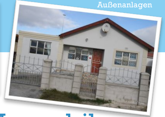
Sibongile 4 mit umgebauter Garage, Rampe und Außenanlagen
